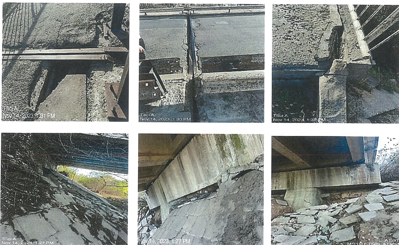
Pasajul superior peste calea ferată în zona porții 10, aparținând SNTFM SA, sursa foto: CNAPM CT
